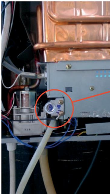
*Orificio de conexión de presión secundaria*
